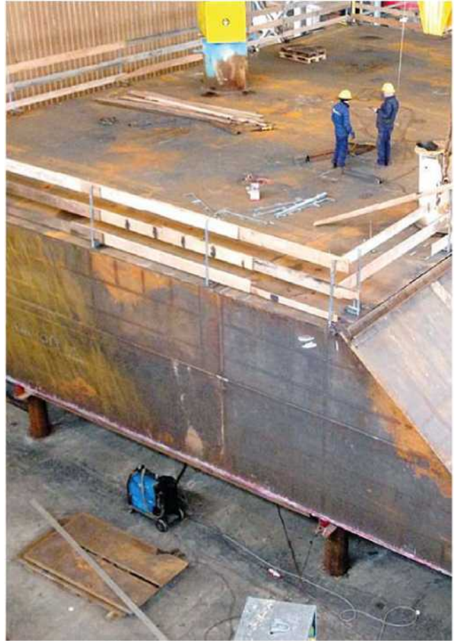
Le paratoie mobili in costruzione
